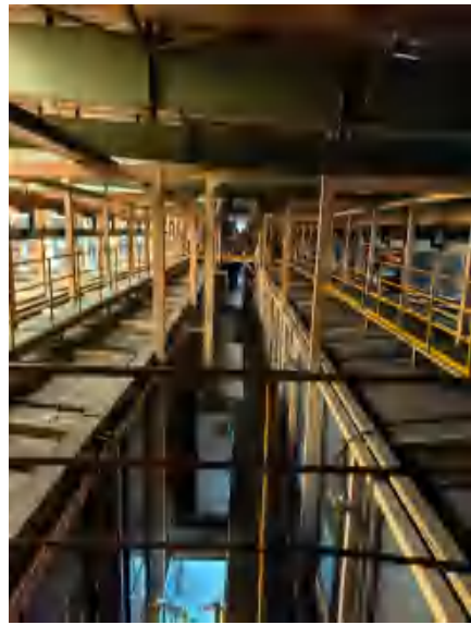
车身涂装车间电泳线区域现状
