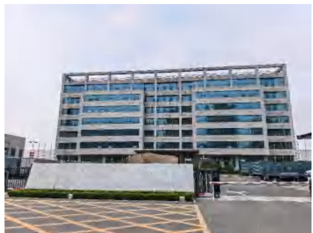
项目厂区大门
