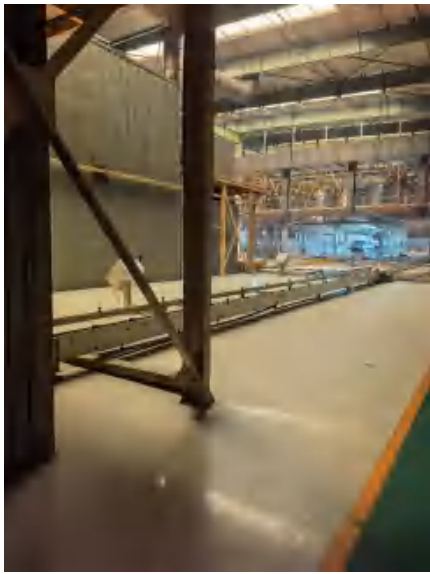
拟延长面漆烘干室区域现状
