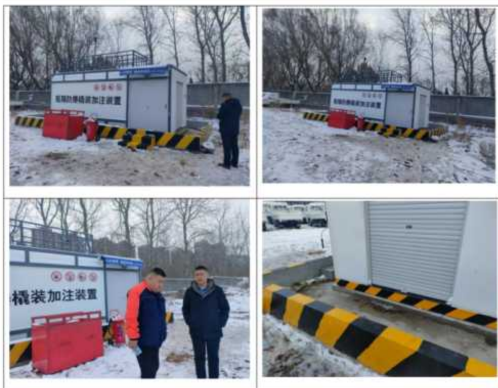
现场验收照片
