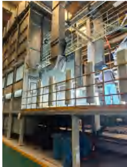
PVC 喷涂操作区域现状
