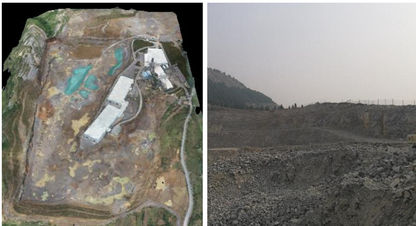
图 3-3 露天采场已损毁土地现状
